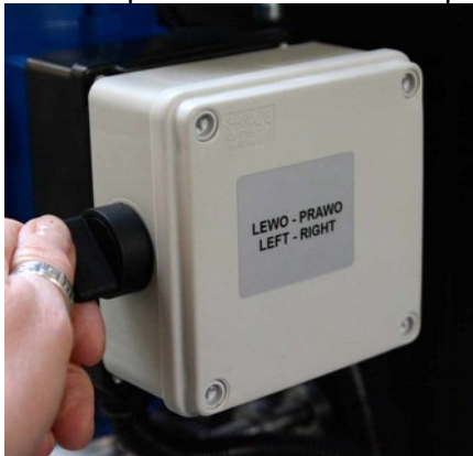
рис. 22 переключатель "ЛЕВО/ПРАВО" прикрепленный к двигателю
